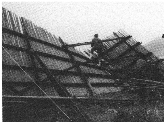
写真1 五十洲、沖への突風によって倒れた間垣とそれを修理する人達
