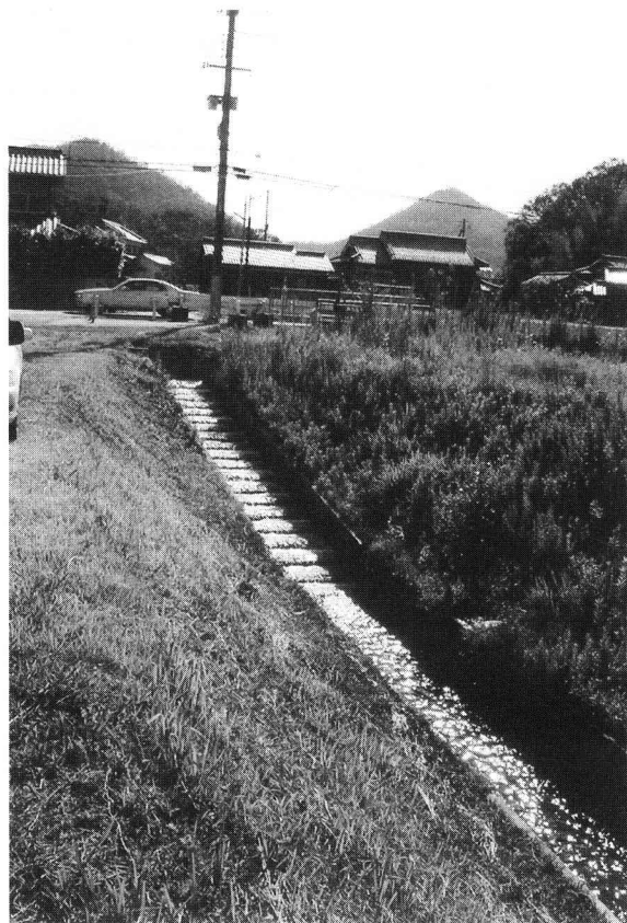
写真1 水田魚道 —兵庫県小野市—
