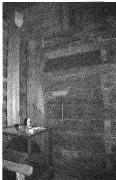
図11 中倉2階東側壁の年輪調査箇所
