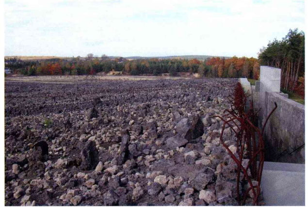
写真2 露出した鉄筋
