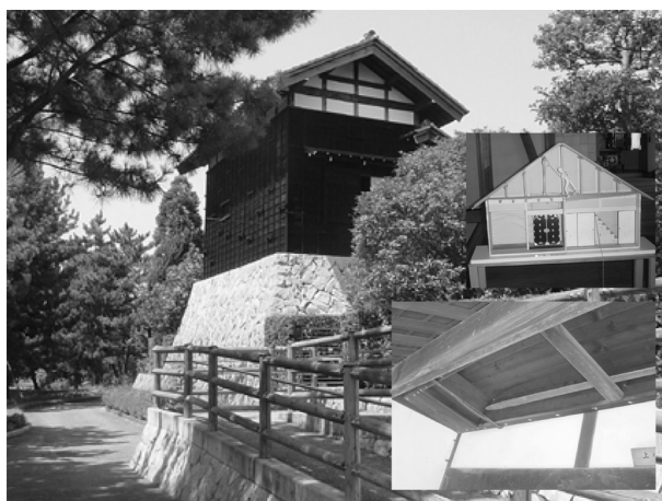
写真2 輪中に見られる水屋。右の差込写真上は上げ仏壇、下は玄関天井に仕込まれた避難用の船 (いずれも木曾三川公園にて撮影)
