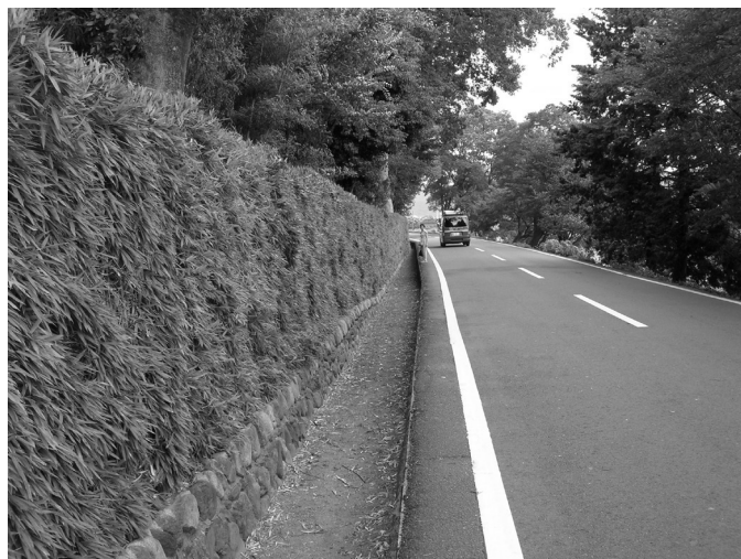
写真3 桂離宮 タケを生かしたまま編み込み、垣根として活用する笹垣(2007年8月2日撮影)
