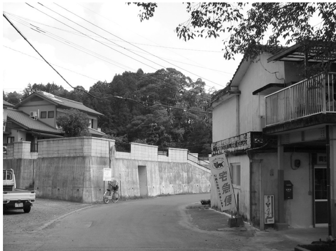
写真10 北川流域の洪水対策のために土台を約3m高上げた住居(奥)。手前の商店は高上げていないため、2004年は2階床上、2005年は1階天井までの床上浸水被災。(2005年9月22日撮影)
