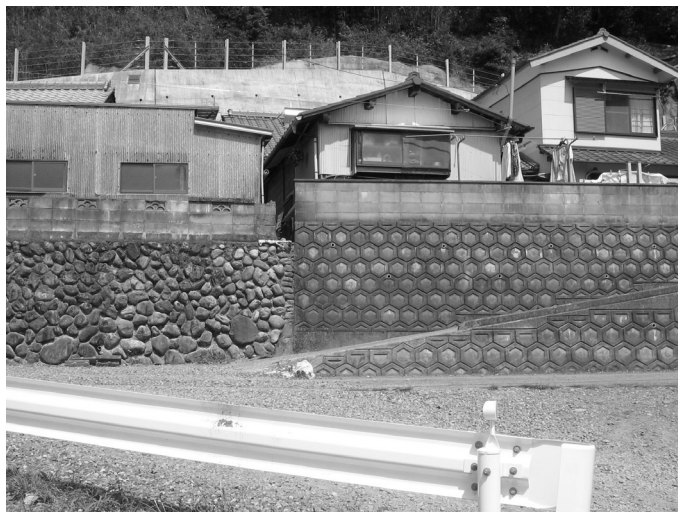
写真8 山裾に3m以上の土盛をなし、かつ輪中のように 防御した北川の住居。(2005年9月22日撮影)
