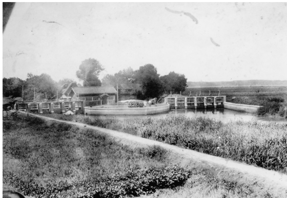
写真2 上流側からみた津幡川の分岐地点 昭和35年撮影。右側が新川、左側が旧川。 山本博氏蔵。
