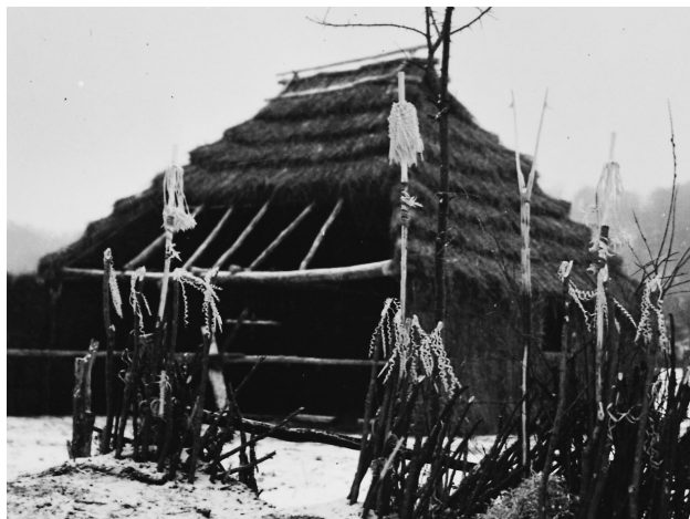
図25 1930年12月 熊送り撮影のための家屋 太陽光を利用するため屋根の草葺きの一部と壁面の一部が開いている。 写真（歴博所蔵 F-387-2-15-220部分）
