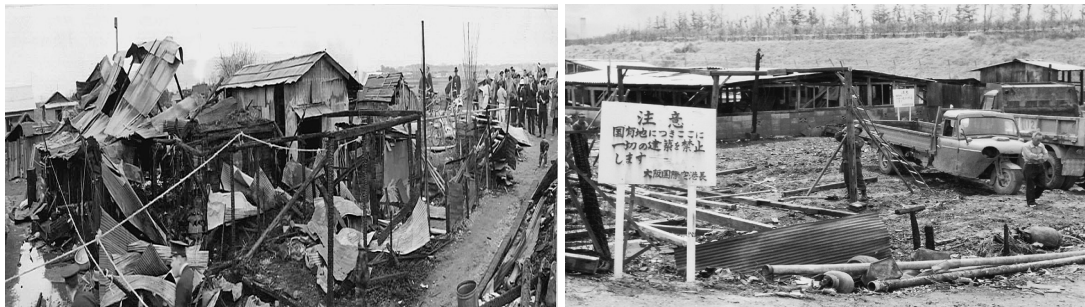
図5 昭和46年4月26日焼失現場(左:航空局提供)・建築禁止の看板(右:航空局提供)
