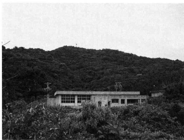
写真-22 元中学校の建物とその裏山付近(2006年5月26日撮影)
