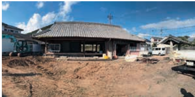
写真4 「裏の屋敷」の取り壊し (2020年 御浜町教育委員会職員撮影)
