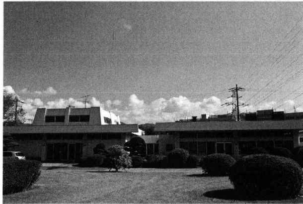
写真4 裾野市営の斎場付き火葬場（裾野市今里・2013年撮影） 1975年の建造で老朽化が進み、市民からは増改築が求められている。
