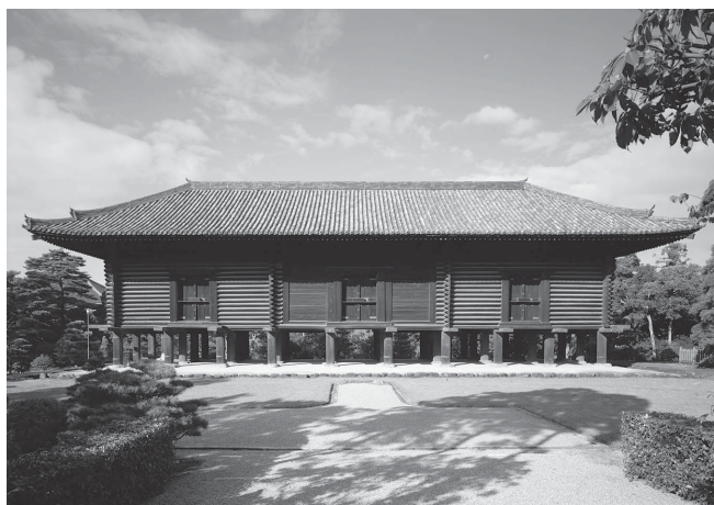
写真1 正倉院正倉の外観 中央の中倉に正倉院古文書が収められていた
