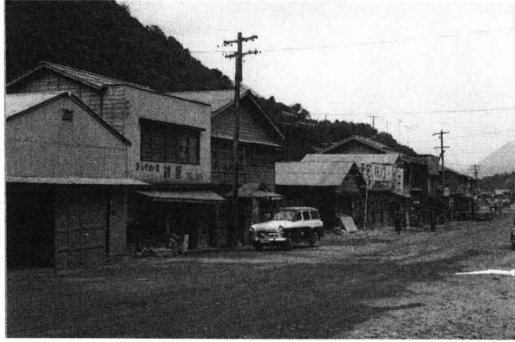
御母衣ダム建設中の御母衣商店街 1961(昭和36)年白川村教育委員会所蔵
