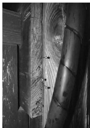
図6 田中3 桁行二階床梁「い通一 - 五」、アカマツ、辺材あり、18世紀後半
