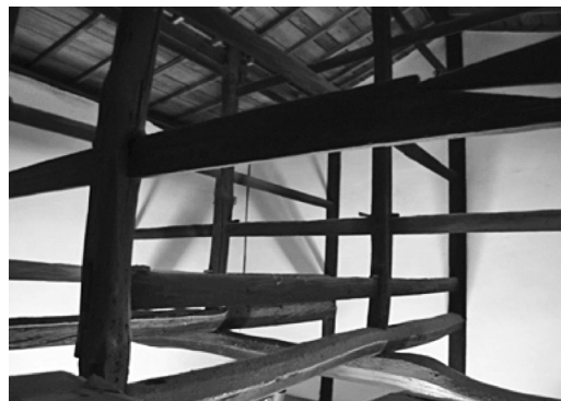
写真 1 若狭家住宅のオウエの吹き抜け架構
