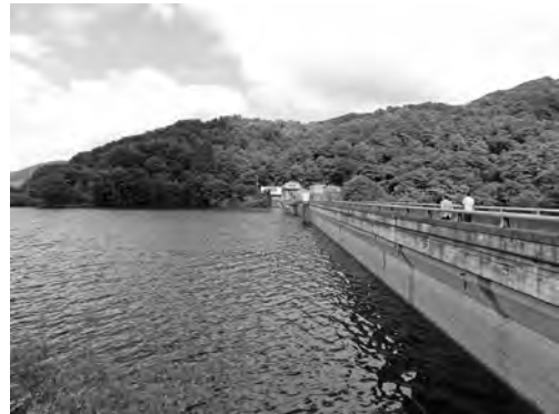
写真3 樽床ダム（昭和32年完成）
