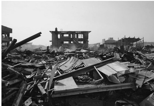
写真15 被災現場写真(山内宏泰撮影)
