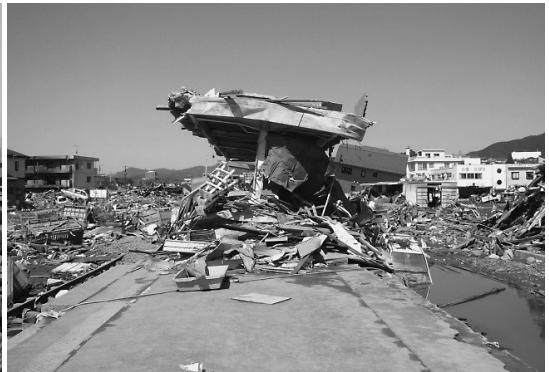
写真16 被災現場写真(山内宏泰撮影)
