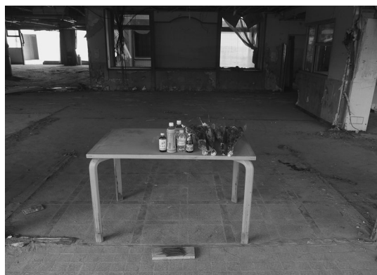
写真2 被災後の老人福祉施設(2011年8月)
