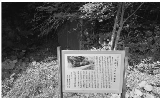
写真2 トンネルと説明板
