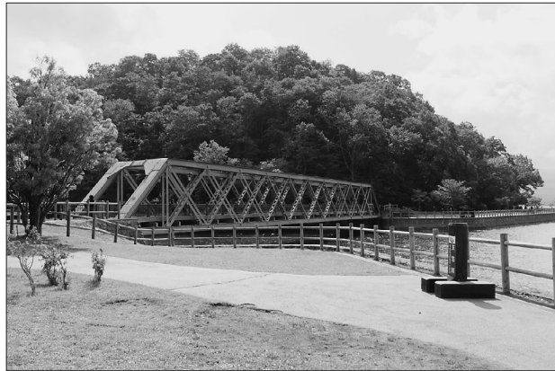
写真 1 現在の山線鉄橋
