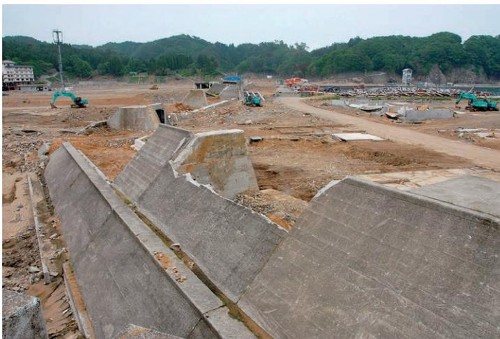
写真1 津波で破壊された防潮堤。高さ10m以上の防潮堤も津波で破壊された(田老町)。
