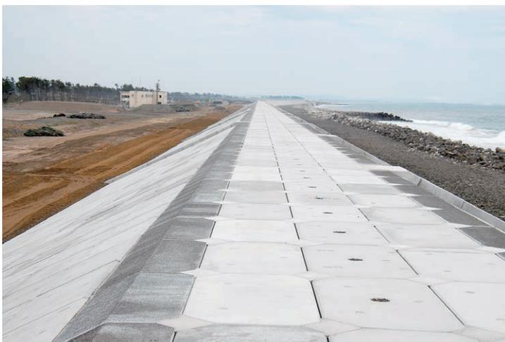
写真2 建設された巨大防潮堤。仙台湾では高さ7mの防潮堤が建設された。
