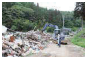
写真2. 気仙沼市の事業にもとづく重機による瓦礫の移動作業
