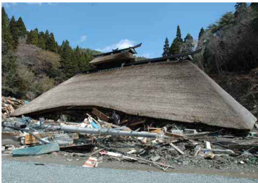
写真3 倒壊して屋根だけが残った尾形家住宅
