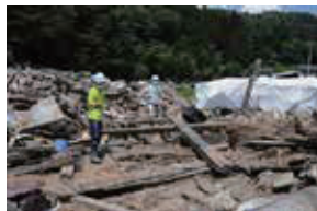
写真1. 柱の除去作業
