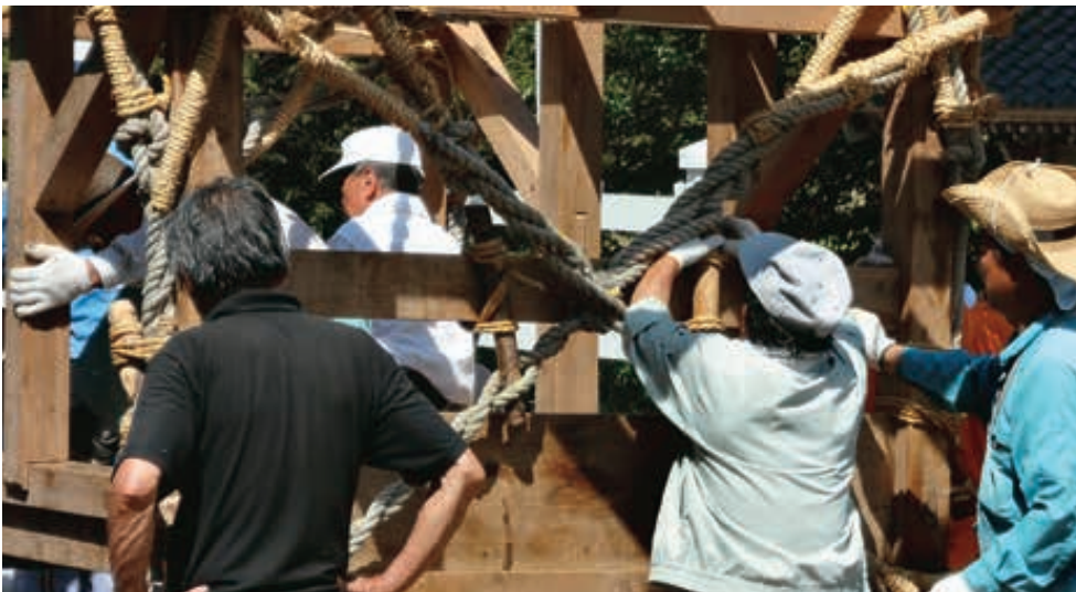
11-12 2本目のネジンをカキ終わり、ネジン棒を固定する。前後のネジンカキでは、ネジン棒を横柱にワラ縄で固定する
