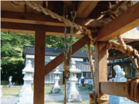
11-18 天守閣につなげたロープもネジンをかけるか、ターンバックルを使って固定する
