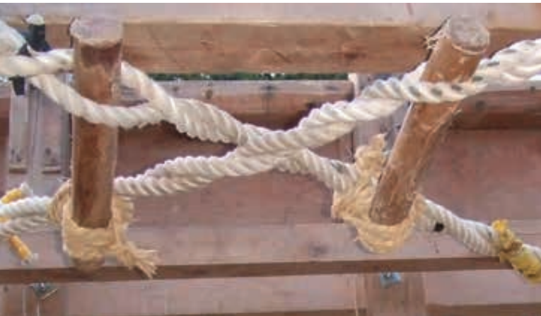
11-3 シタヤマにかけたネジンのようす。ロープが幾重にもねじられ、そのロープにネジン棒が固定されている
