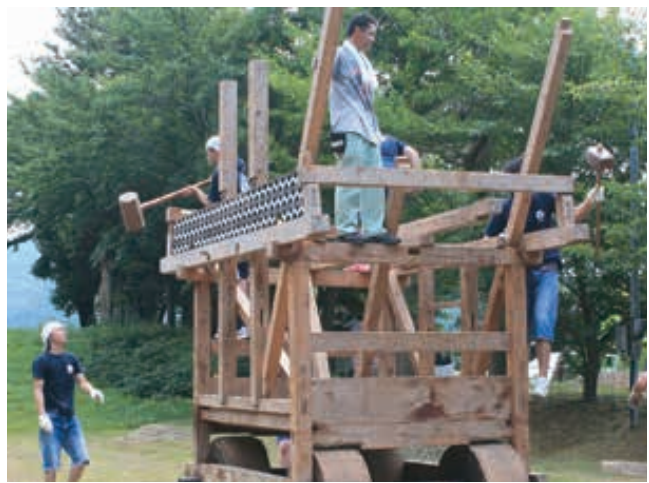
10-13 前後に斜めの柱を挿入して固定する。全体的なゆがみなどではまりにくい場合には、巨大な木槌などを用いる
