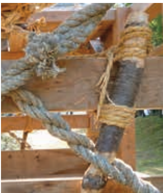
11-14 横柱に固定されたネジン棒
