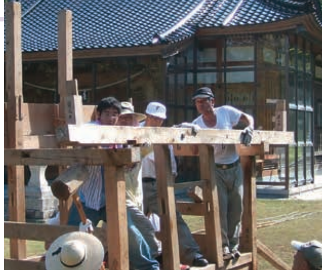
10-11 出入口側の柱や中央の横柱も据えていく
