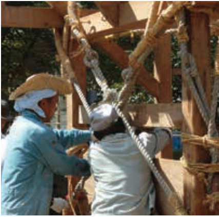
11-11 柱と柱の間に棒をまわして、ネジンをカクが、徐々に回しにくくなる
