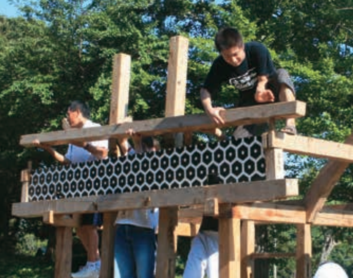
10-12 石垣の上に柱を据え、同じ高さの中柱も設置する
