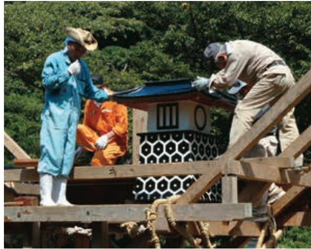
11-15 最初に天守閣用の板をタカヤマに据え、その上に天守閣のパーツを設置する
