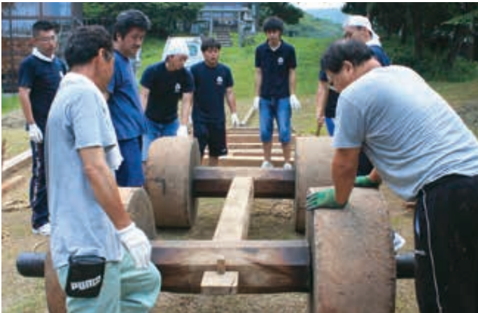
10-4 前後の車軸に横柱をつなぐ。土台となるこの部分は、抜けないように木釘を打ちこんで固定する
