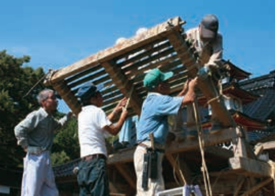
11-20 柱にダシダケを括る。タケ一筋ごとにワラ縄を柱に巻く根気のいる作業である
