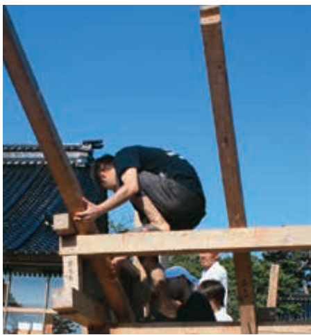
10-14 斜めの柱を調整する
