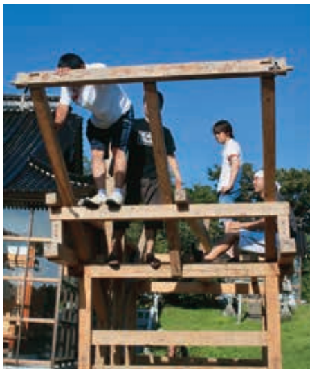
10-15 斜めの柱の先に横柱をはめこむ。不安定な足場のため、力が入りにくい
