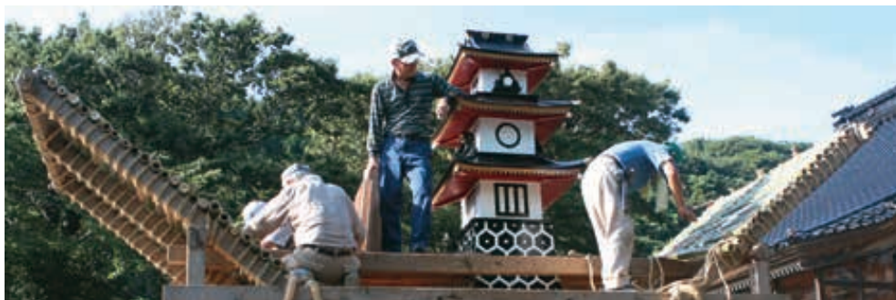
11-21 ダシダケを括ったうえで、継ぎ足しに必要なタケの本数を確認する
