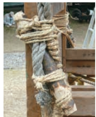
11-8 縦柱に固定されたネジン棒
