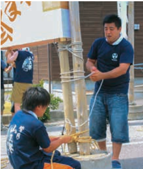
3-16,17 軸棒 おもし に乗せてバランスと方向を調整し、ロープとワラナワで支柱に固定する
