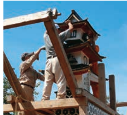
11-17 3段目を据えて内側からロープを通す
