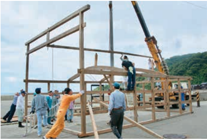
9-2 御飯屋の骨組みを組立てる様子。棟木をクレーン車で吊りさげている
