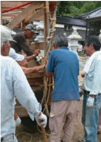
11-7 ネジン棒をワラ縄で縦柱に縛りつけ固定する
