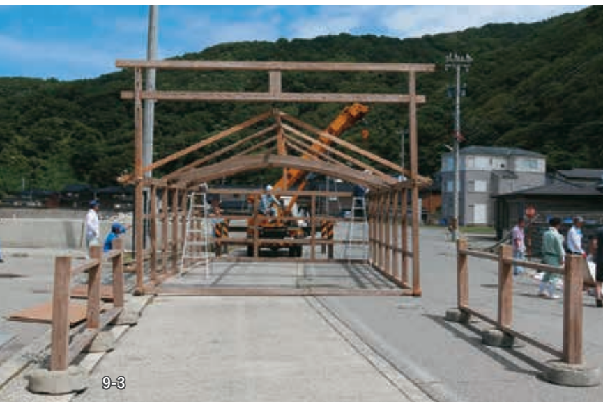
9-2 御飯屋の骨組みを組立てる様子。棟木をクレーン車で吊りさげている
