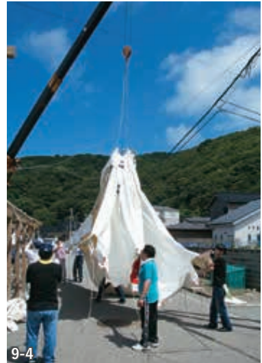
9-4,5 クレーン車でシートを吊りあげ、屋根に設置する。正面の留め金に固定すれば、巴の印も正面にくる
