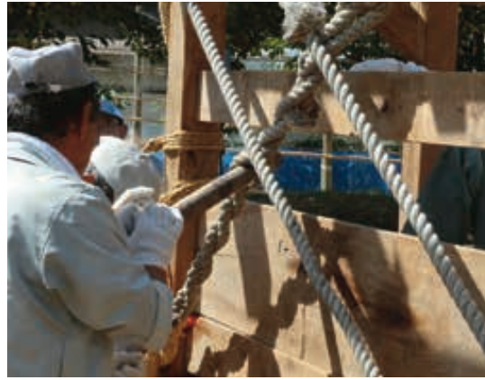
11-10 ロープにネジン棒を入れてねじっている。前後のネジンは、必ず車軸のネジンの上にかぶせる
