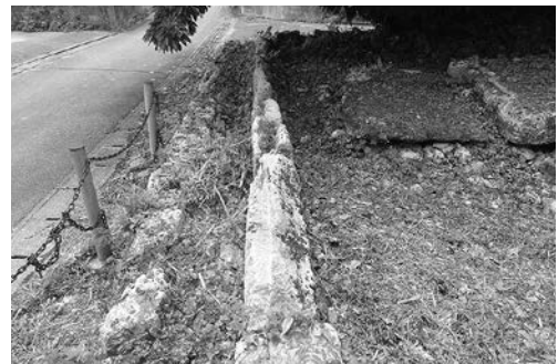
図6 久貝ブサギ外囲い上端部
