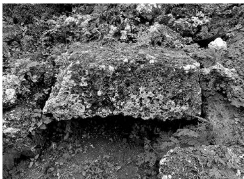
図12 スサビミャーカ外側外囲い石材 (外側に対して控えが窄まる)
