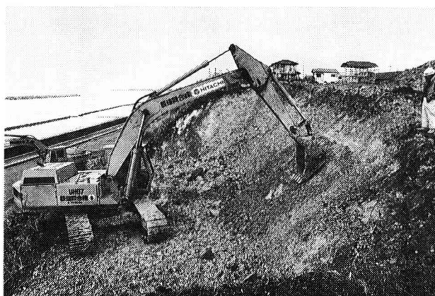
図19 バックホーを用いてⅠ～Ⅳ層を除去
