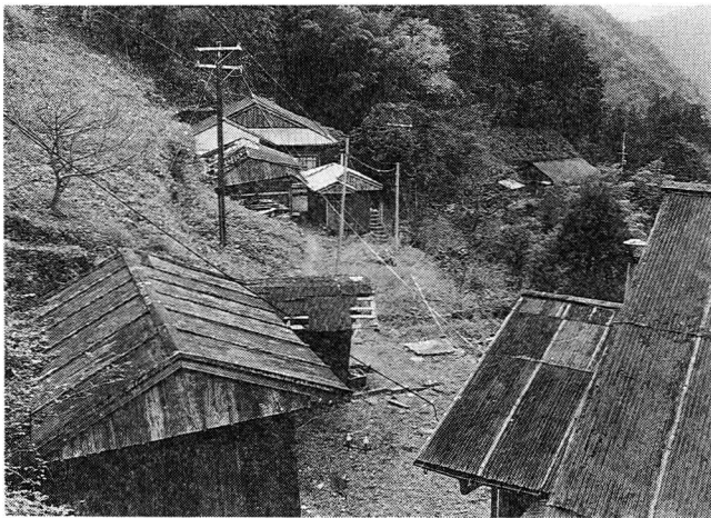
写真1 天ヶ瀬の廃屋
