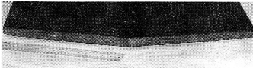
写真2 制札A 天部木口の釘穴（屋根の跡）
