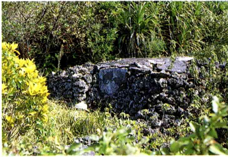
(61) 波照間島の墓は家族単位につくられる。その形態にはおよそ3つある。これはもっとも古いと思われるサンゴの石でできた墓。四方をサンゴの石で積み上げ、中央に大きな石で蓋をする。前面には60センチ四方程度の入り口を設ける。
