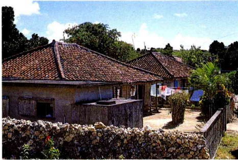
(1) 波照間島の家屋。波照間島の集落は台風を防ぐために家屋の周囲にはフクギなど風に強い木々で囲まれている。家屋の周囲にはサングの塀があり、門口を入るとこの写真にもあるように、ヒンプンがある。また、波照間島は水がしばしば不足するので、天水を溜めるタンクが各家に備えつけられている。
